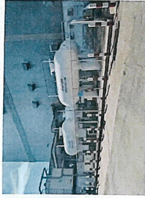
รูปที่ 1, 2 ภาพแสดงสภาพโดยทั่วไปของถังเก็บและจ่ายก๊าซปิโตรเลียมเหลวชนิดติดตั้งบนพื้นดิน
